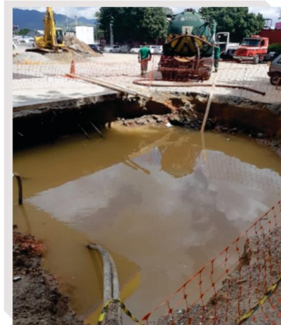
contato com o solo. Sua origem não foi esclarecida porque a mesma percolava de dentro de uma das paredes da escavação. O acúmulo de água local pode ter sido motivado pelas chuvas na região ou por alguma tubulação com vazamento nas proximidades, que percolou para dentro da cava. Foram transportados e destinados adequadamente 405 toneladas de solo e 96m<sup>3</sup> de água contaminados.
